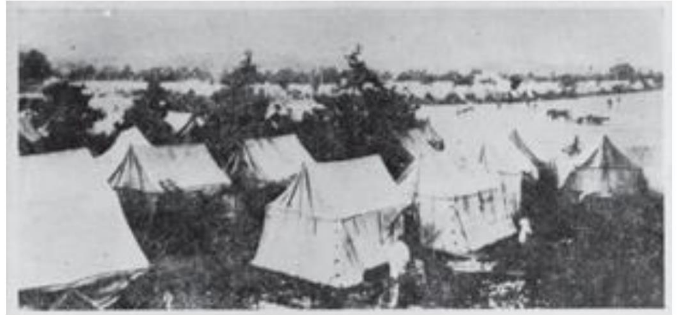
1923年に発生した関東大震災では テント500張りを納入（写真は皇居前広場のテント村）
